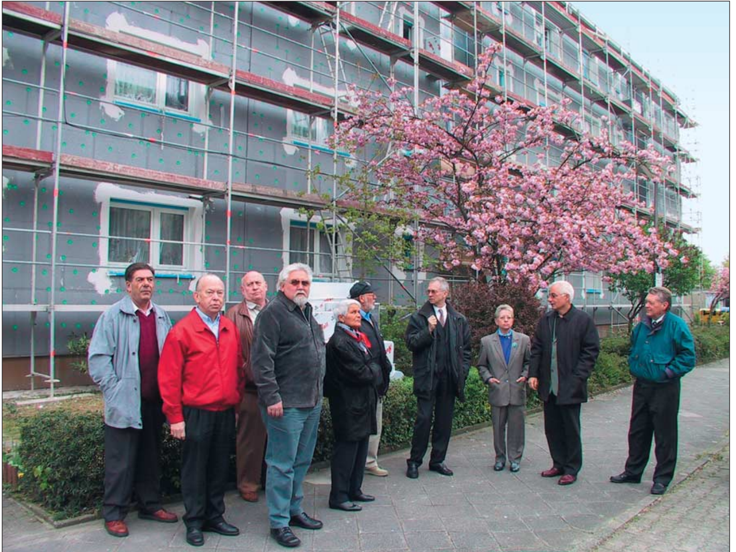
Aufsichtsrat und Vorstand besichtigen die Modernisierungsmaßnahmen im Zwickauer Weg 1-11
